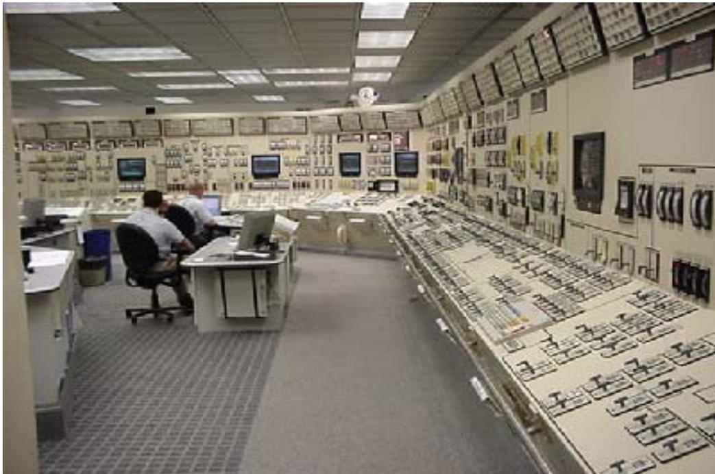
**Figura 2.5** – Sala de controle de subestação da década de 1970, com operação através de instrumentos e sinalização de alarmes em anunciadores (Quadro de alarmes apresentados na parte superior dos painéis).
