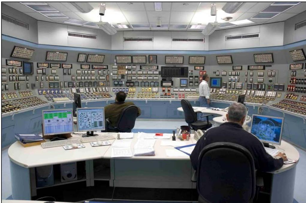
**Figura 2.7** – Sala de controle da Usina Nuclear Angra 2. Ao fundo painéis convencionais com instrumentos e anunciadores de alarme (topo). Nas mesas de operação, console com IHM digital.
