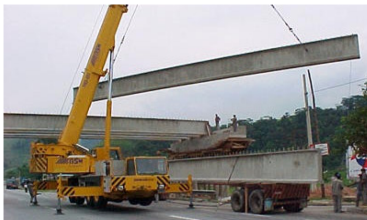
Figura 27 - Exemplo de içamento de viga no local da obra (site da Premag – RJ, 2007)
