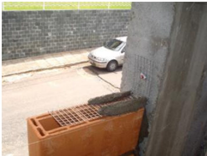
Fig.20 – Fixação na ligaçãoalvenaria-estrutura
