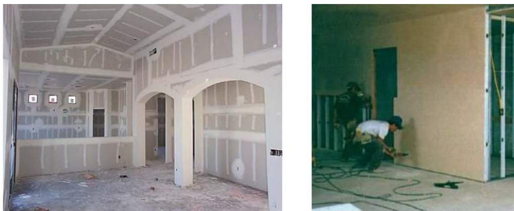
Figura 4 – Exemplo de Gesso acartonado
