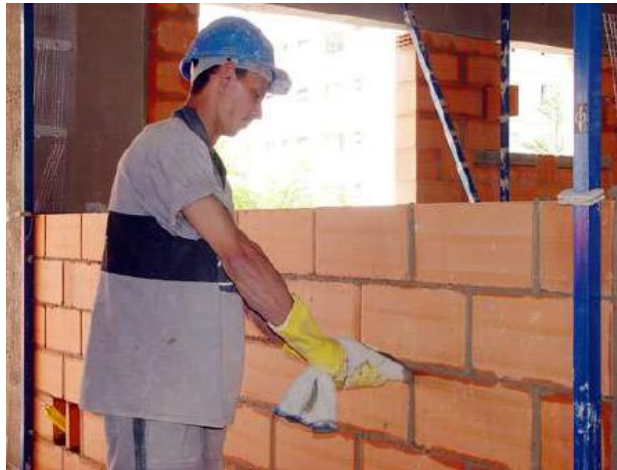
Fig.22 – Preenchimento das juntas verticais
