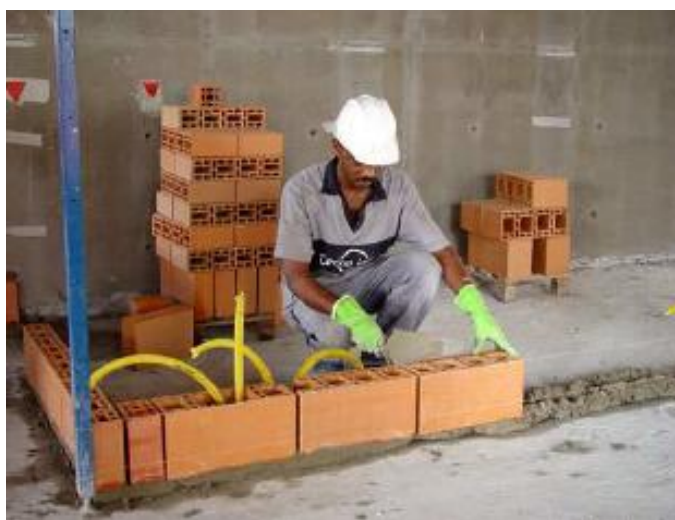
Fig. 5 – Marcação da alvenaria racionalizada
