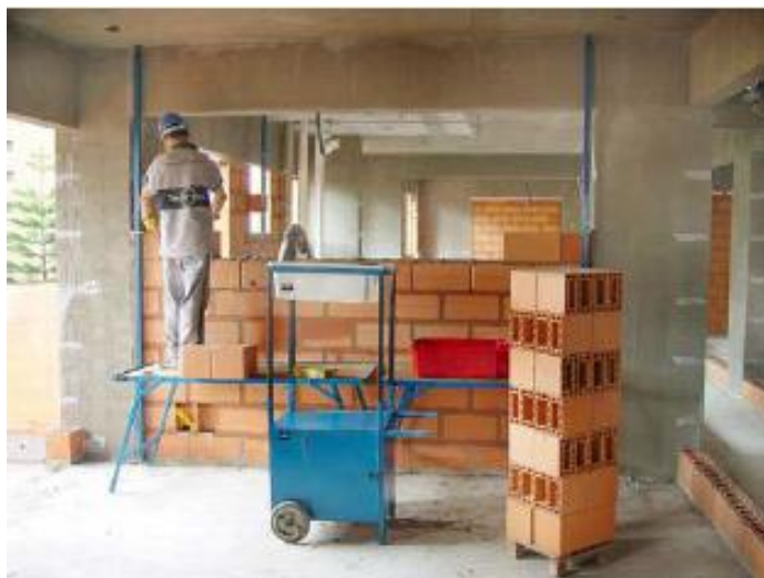
Fig.6 – Elevação da alvenaria racionalizada
