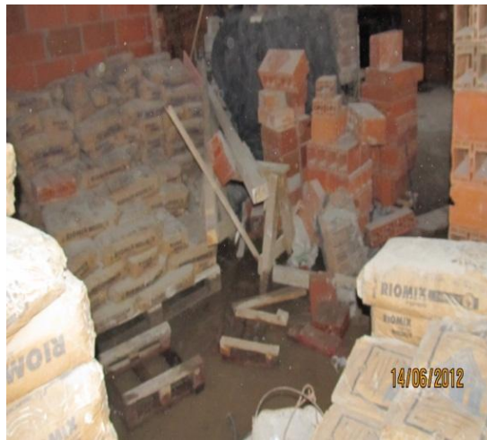
Fig.33 – Exemplo de estocagem indevida
