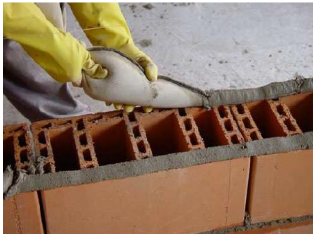
Fig.23 – Preenchimento das juntas horizontais
