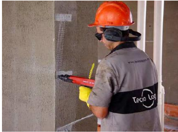
Fig.21 – Fixação da tela metálica
