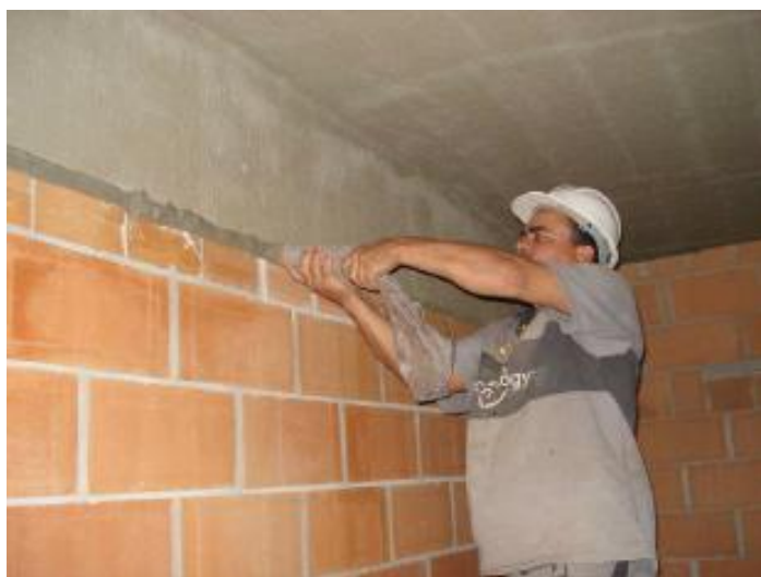
Fig.7 – Fixação da alvenaria racionalizada
