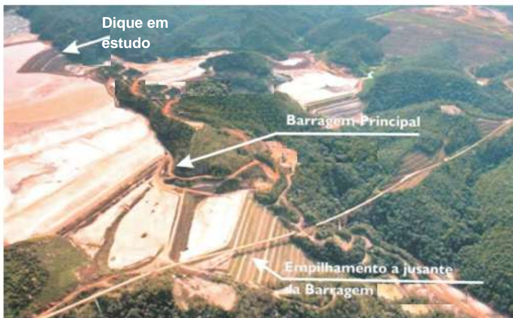
Figura 24-Visão geral da barragem principal e localização dos diques (Modificada de Ávila, 2012)
