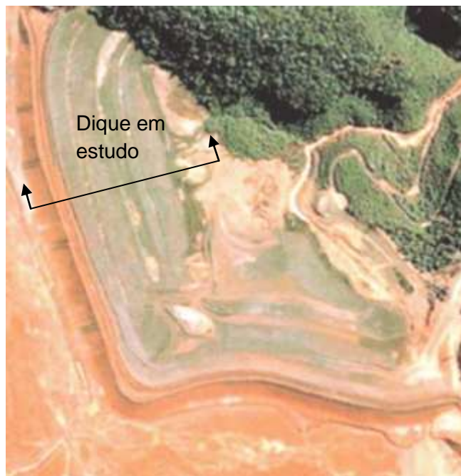
Figura 26-Vista aérea dos diques (Modificada de Ávila, 2012)
