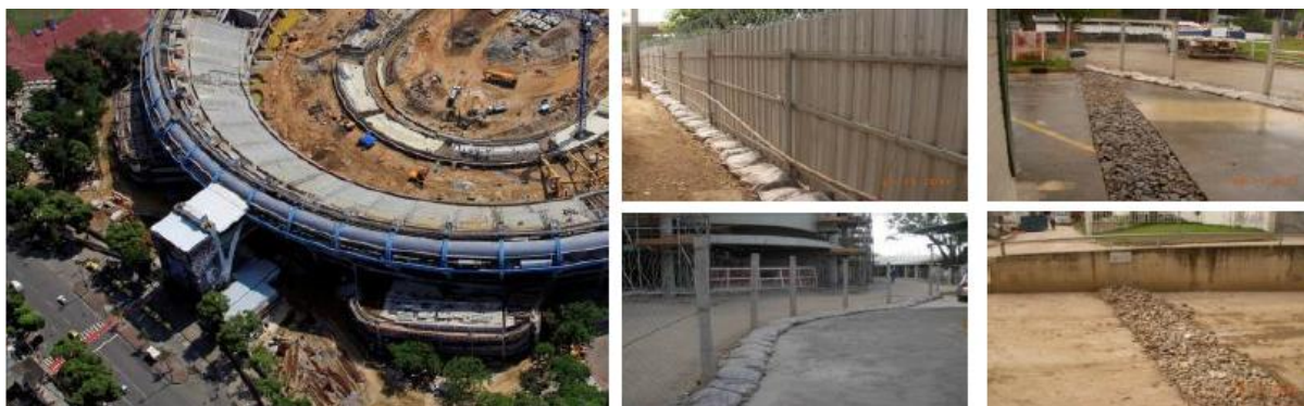
Figura 18 – Trincheiras de Contenção
