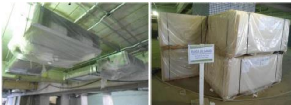
Figura 30 – Equipamentos de Ar Condicionado e Gesso Acartonado protegidos por lona
