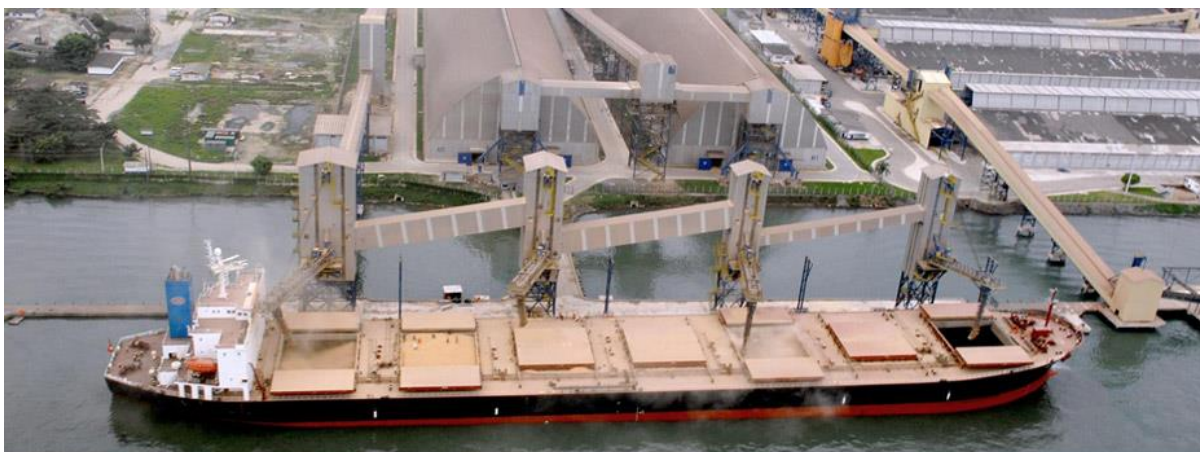
Figura 19 – Porto de Santos – Terminal de Granéis do Guarujá - Fonte: Site da Empresa
