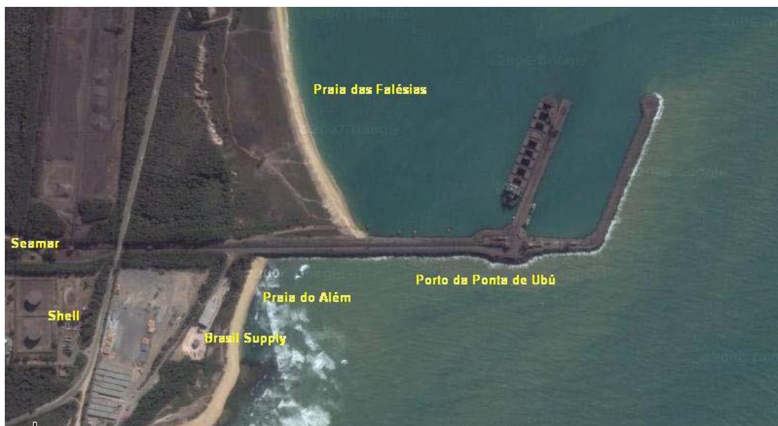
Figura 11 – Píer Terminal de UBU - Fonte: Apresentação Terminal de UBU
