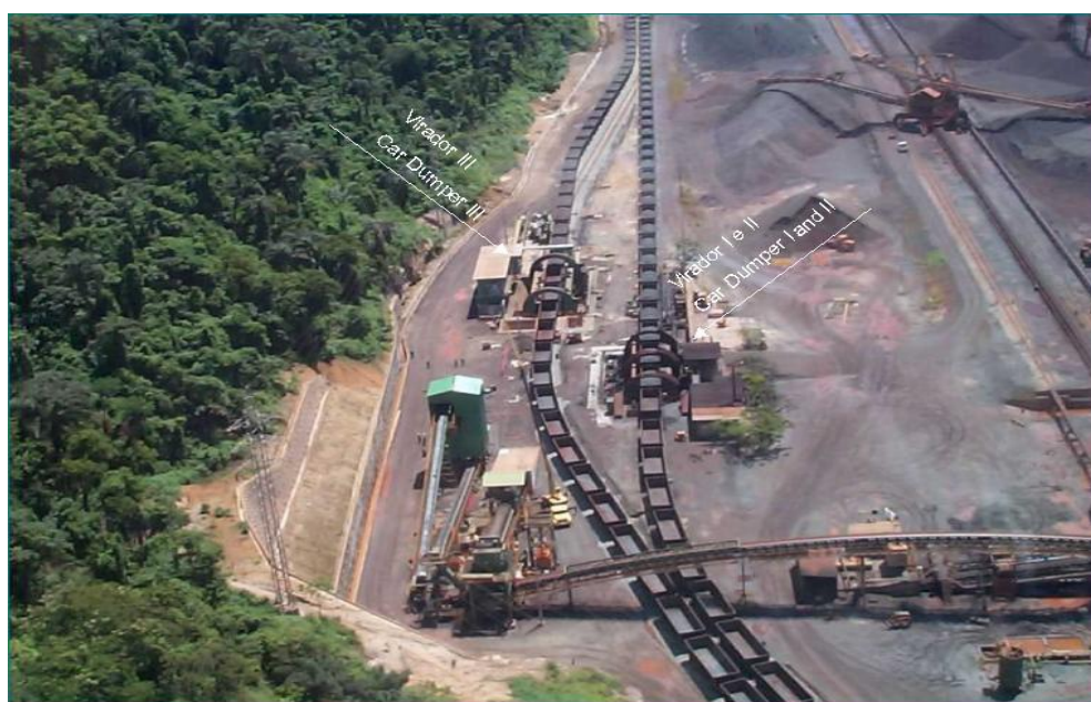
Figura 7 – Viradores de Vagão TIG - Fonte: COSTA,2006
