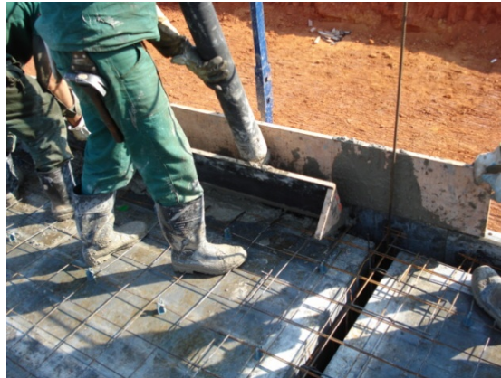
Figura 47. Lançamento do concreto nas paredes.
