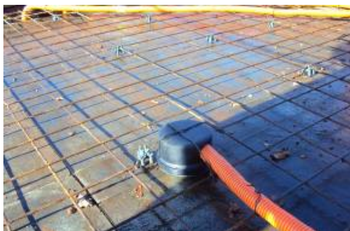
Figura 50. Pontos de elétrica embutido na laje.
