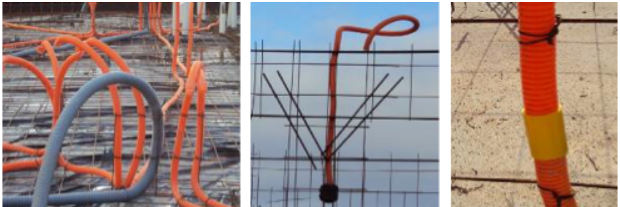
Figuras 51, 52 e 53. Instalações elétricas embutidas nas paredes de concreto.
