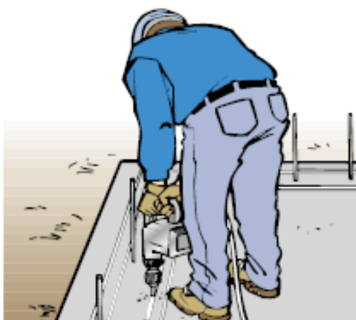
Figura 15. Fixação dos espaçadores.
