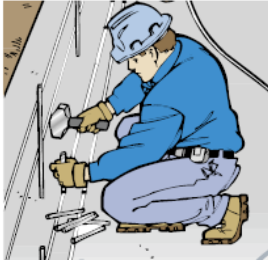
Figura 16. Fixação dos arranques.
