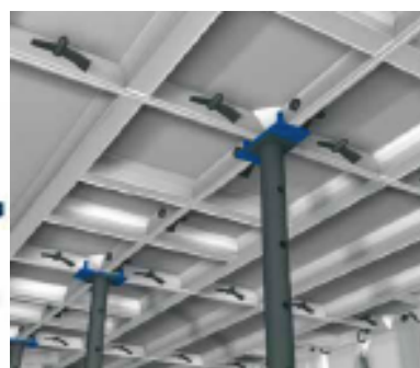
Figuras 6 e 7. Peça utilizada no escoramento das lajes e utilização da mesma, respectivamente. (Fonte: Manual técnico do fabricante, 2011)
