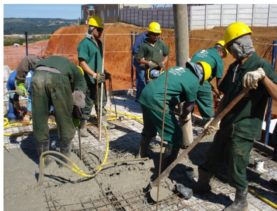
Figura 48. Lançamento do concreto nas lajes.
