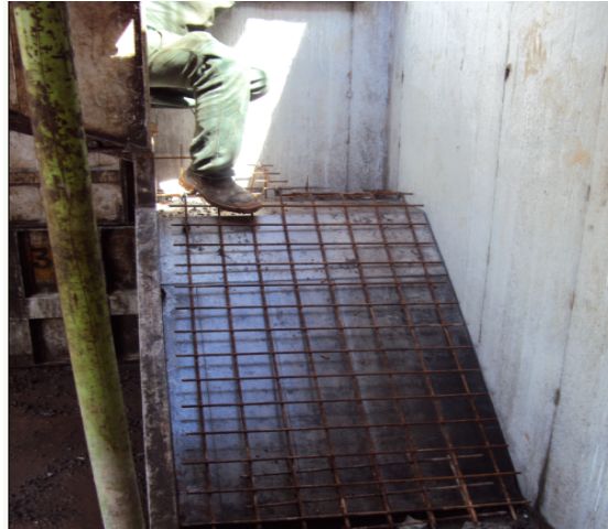
Figura 32. Assoalho executado e armado.
