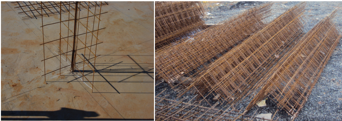
Figuras 39 e 40. Armações de canto, posicionadas e em estoque, respectivamente. (Fonte: Caderno de encargos da construtora, 2011)
