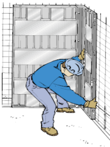
Figuras 19 e 20. Posicionamento dos painéis e posicionamento dos pinos, respectivamente.
