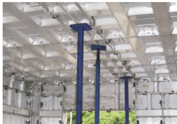
Figura 31. Uso de escoras metálicas. (Fonte: Caderno de encargos da construtora, 2011)
