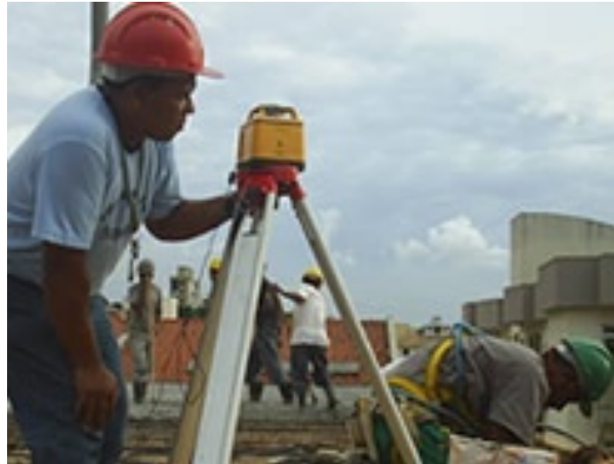
Figura 49. Verificação com nível a laser.
