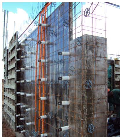
Figura 24. Fechamento dos painéis externos.
