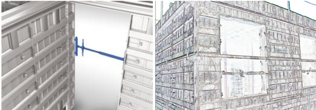
Figuras 25 e 26. Escoramento dos vãos das portas e janelas.
