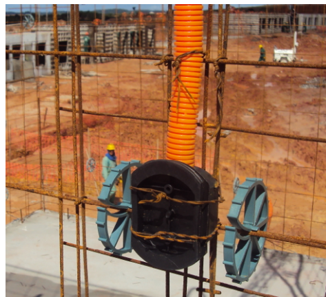
Figura 43. Caixa elétrica posicionada adequadamente. (Fonte: Caderno de encargos da construtora, 2011)
