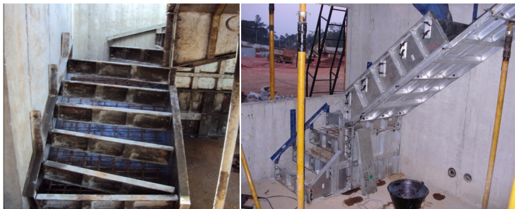
Figuras 33 e 34. Posicionamento dos espelhos dos degraus e forma finalizada, respectivamente.
