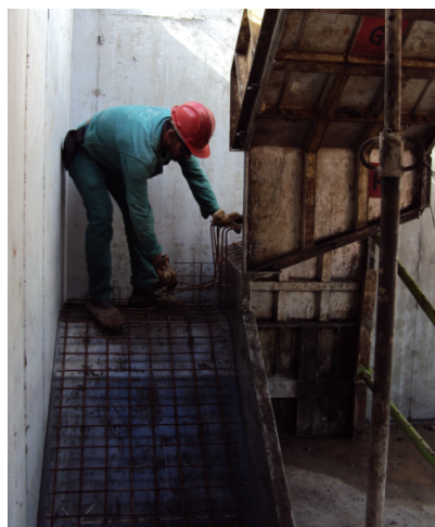
Figura 44. Armação da escada. (Fonte: Caderno de encargos da construtora, 2011)
