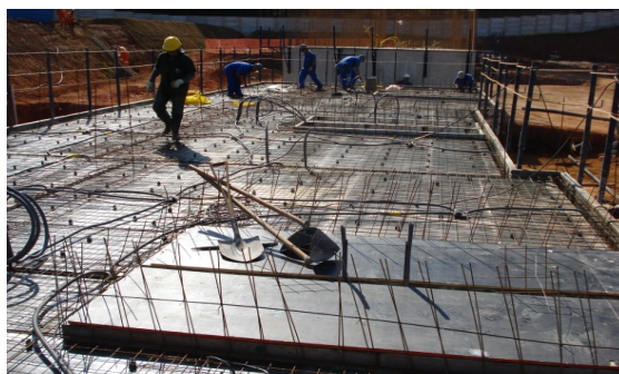
Figura 45. Laje e paredes prontas para concretagem. (Fonte: Caderno de encargos da construtora, 2011)
