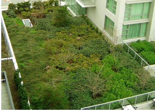
FIGURA 18 – Telhado Verde Intensivo em um edifício em Toronto-Canada.
