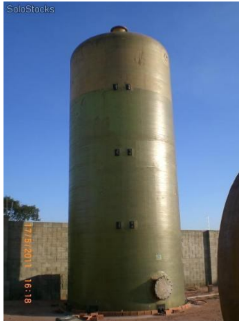
FIGURA 27 – Reservatório de Fibra de Vidro.
