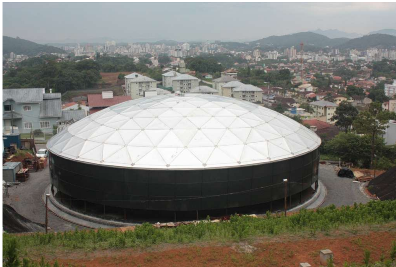
FIGURA 28 – Reservatório de Aço.
