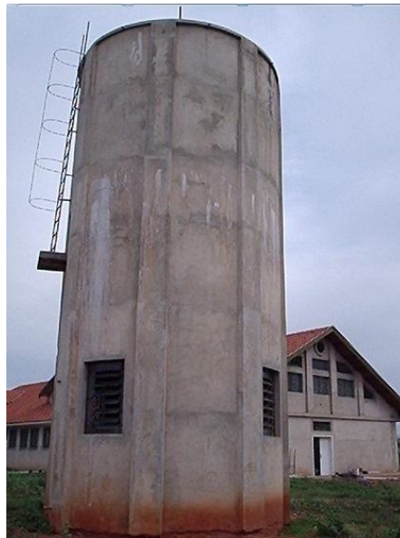
FIGURA 25 – Reservatório de Alvenaria.
