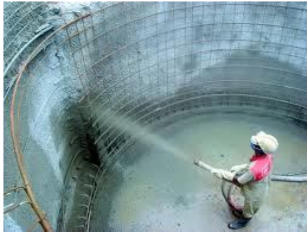
FIGURA 26 – Reservatório de Concreto.
