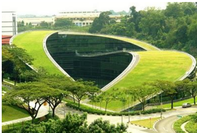
FIGURA 17 – Telhado Verde Extensivo da Escola de Arte, Design e Multimídia da Universidade Tecnológica de Nanyang.
