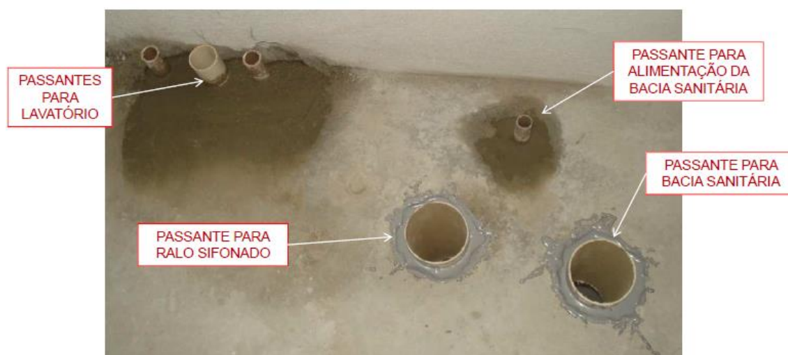
Figura 24: Exemplo de chumbamento dos passantes. Fonte: Acervo da autora.
