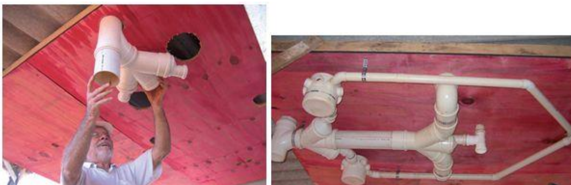
Figura 23: Gabarito para locação de pontos e confecção dos kits. Fonte: Romário Ferreira, Fevereiro de 2013.
