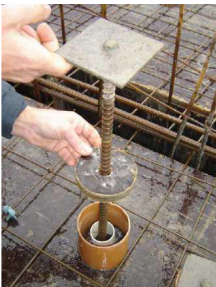
Figura 21: Marcação dos pontos na laje. Fonte: Acervo da autora.
