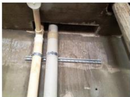
Figura 22: Prumadas fixadas por meio de perfilados metálicos. Fonte: Acervo da autora.
