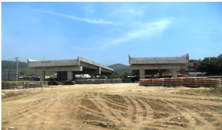
**Figura 8 - Futuro encontro entre viaduto e aterro com fitas metálicas em Sulacap, RJ. (Autor)**
