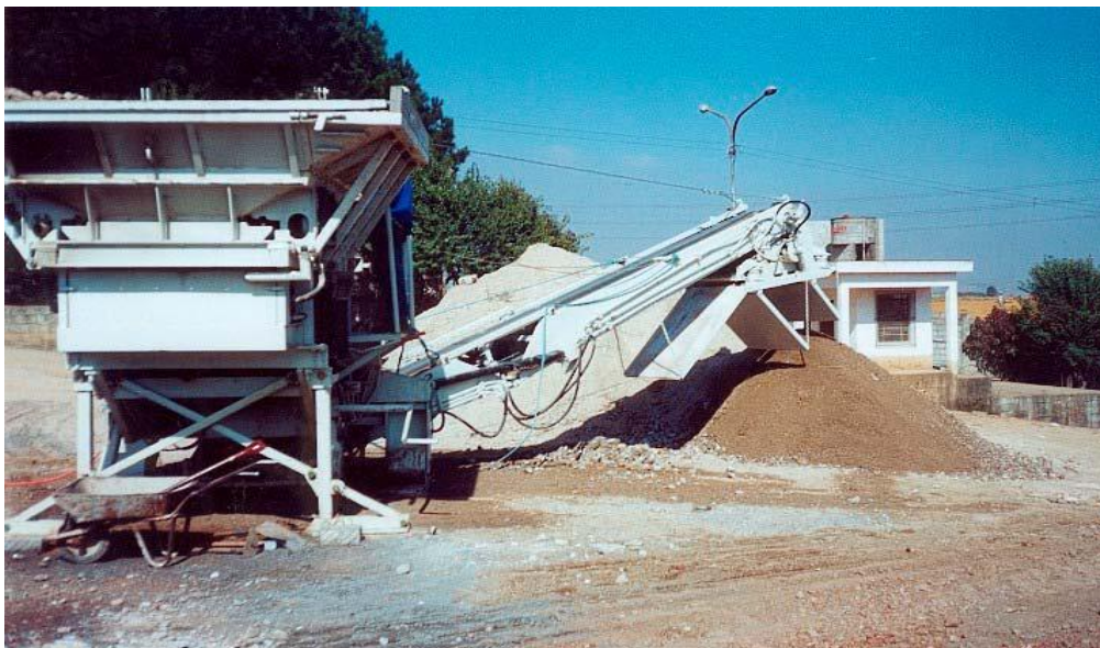
Figura 4: Área de reciclagem privada.
