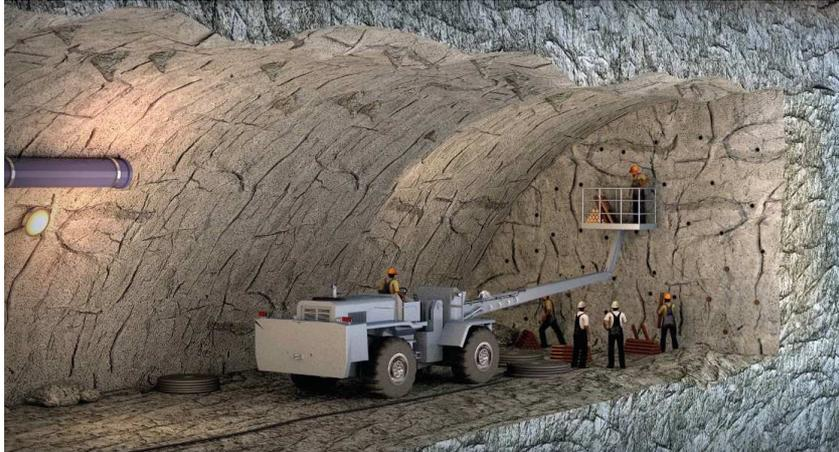
Figura 15 – Carregamento da frente de escavação
