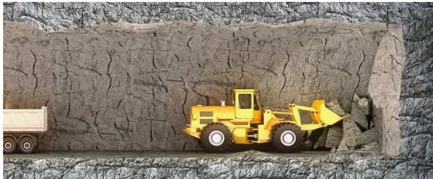
Figura 17 – Limpeza da frente de escavação
