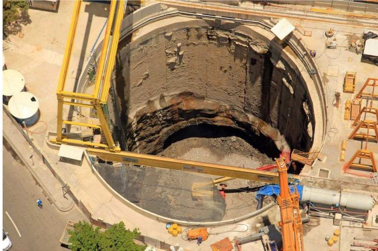
Figura 36 – Vista aérea do poço com pórtico para içamento de cargas
