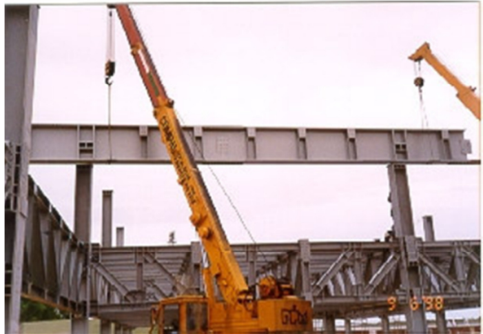
Figura 12 - Montagem de estrutura metálica. (www.ufsm.br, 2013)
