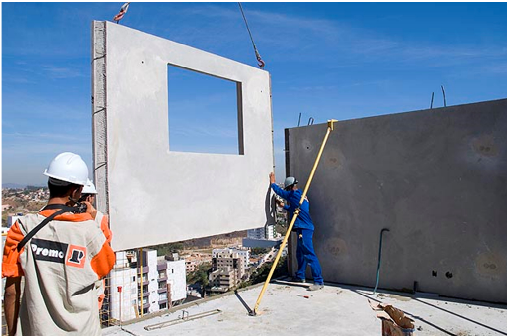
Figura 32 - Montagem de uma parede pré-fabricada ( http://comunidade.maiscomunidade.com , 2014)
