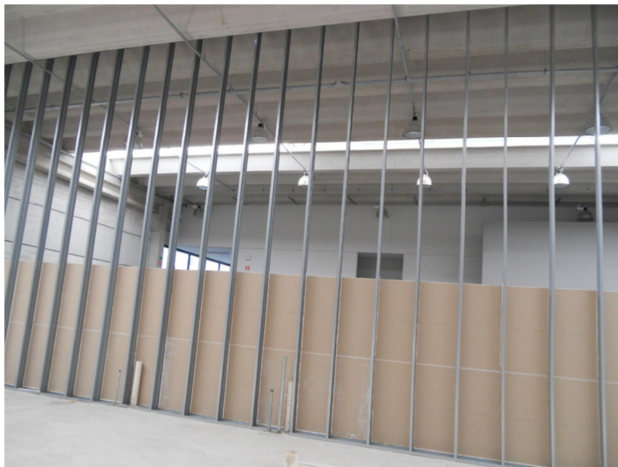
Figura 19 - Estrutura da parede montada ( www.facilitieservicos.com.br , 2013)
