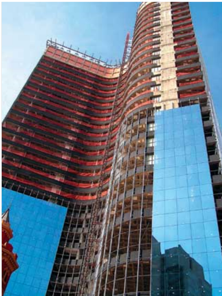
Figura 28 - Montagem dos painéis modulares. (www.arcoweb.com.br, 2014)
