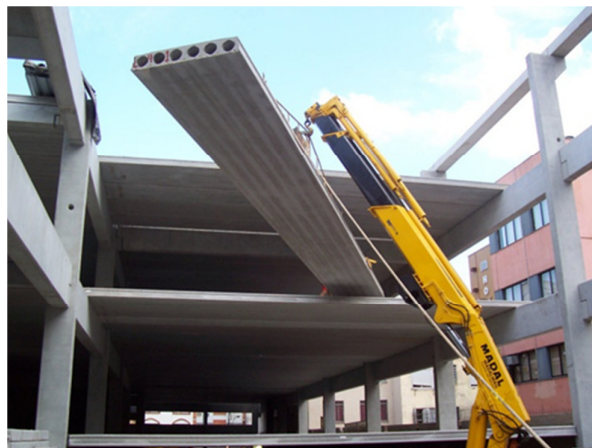
Figura 10 – Içamento de laje alveolar para posicionamento na estrutura (www.adove.com.br, 2014)
