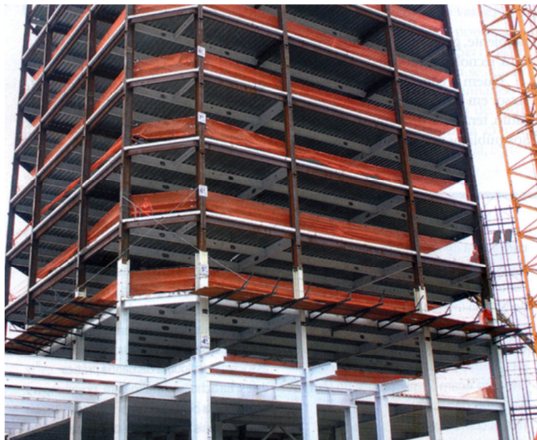
Figura 14 - Estrutura metálica montada. ( http://www.cbca-acobrasil.org.br/ , 2013)
