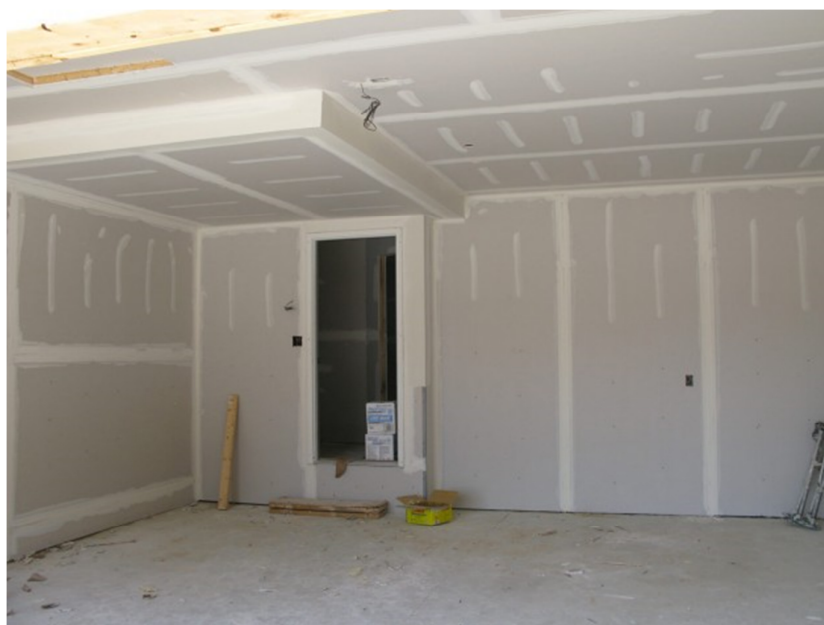
Figura 23 - Parede de drywall com acabamento das juntas (www.lojaskd.com.br, 2014)
