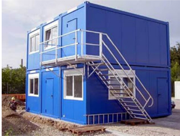
Figura 5 – Exemplo de Arranjo de containers ( http://sp.quebarato.com.br , 2014)
