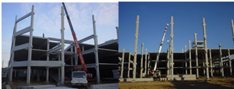
Figura 9 – Montagem de estrutura de concreto pré-moldado ( www.mwguindastes.com.br , 2014)
