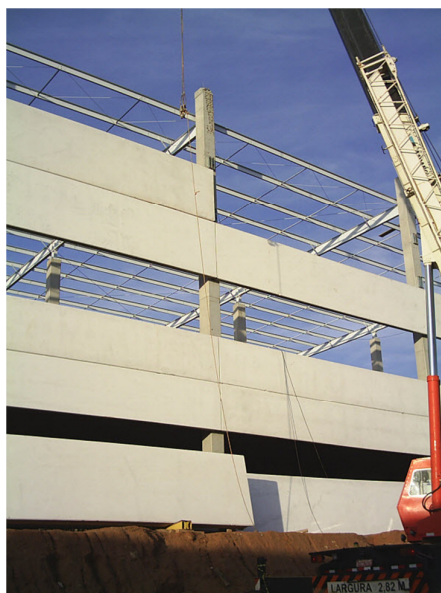
Figura 42 - Montagem de fachada pré-fabricada. ( http://www.perville.com.br , 2014)
