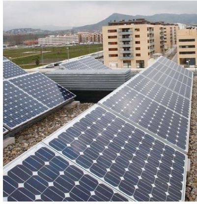
Ilustración 92: Instalación de energía fotovoltaica
