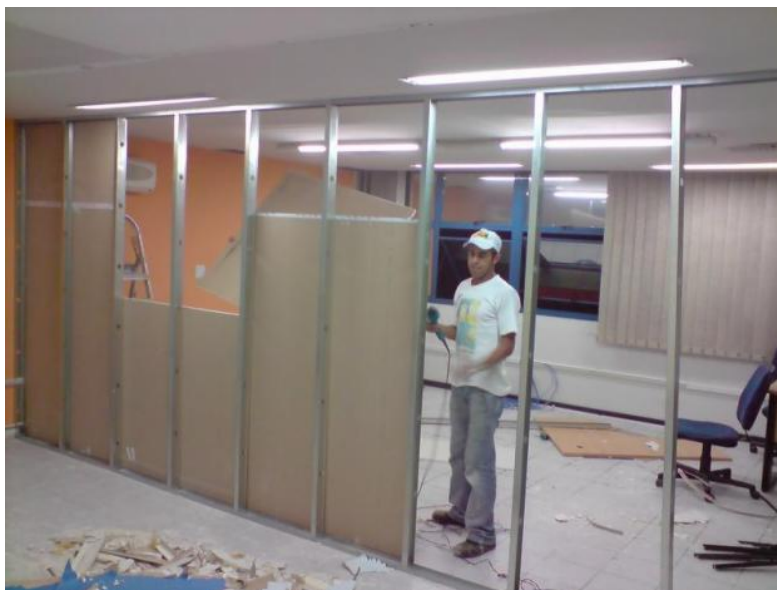
Figura 23– Vedação em Drywall (PLANEJADOS EM DRYWALL,2012)
