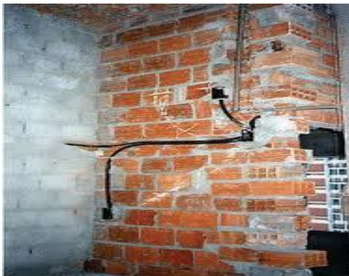
Figura 8- Quebra de material para fixação de caixas de luz (PAULUZZI,2014)
