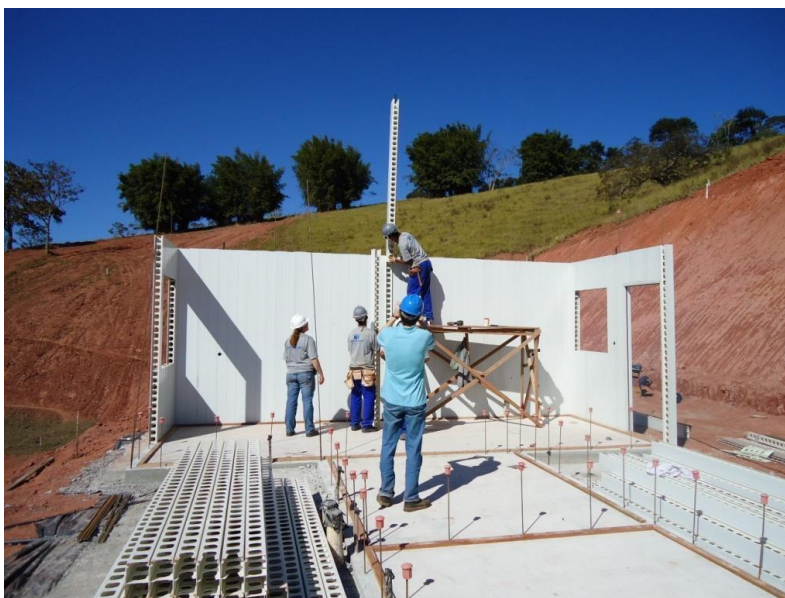
Figura 21– Construção com o sistema concreto-pvc (CIMENTO ITAMBÉ,2011)
