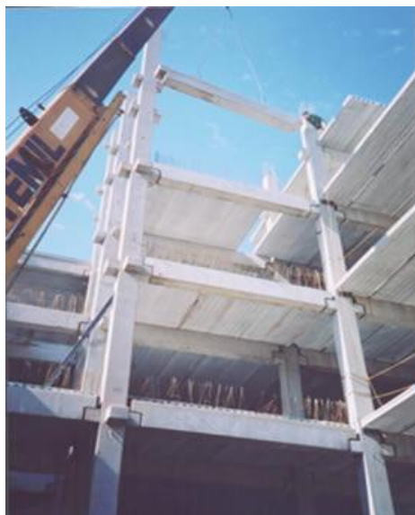
Figura 22 – Construção de um edifício em concreto pré-fabricado (VTN,2014).
