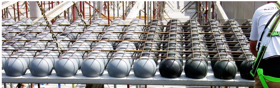
Figura 16 – O sistema BubbleDeck (BUBBLEDECK,2014)
