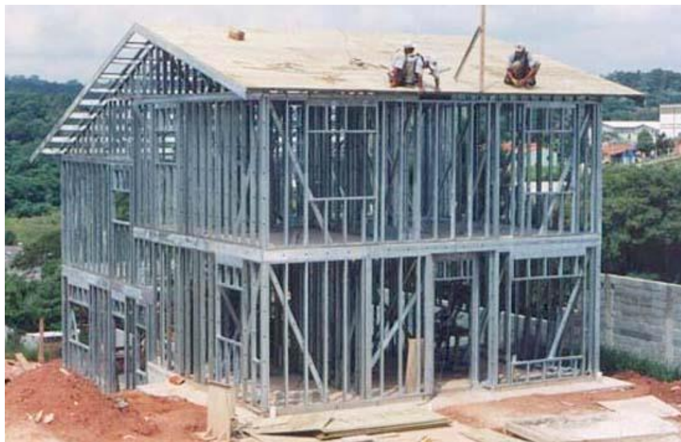
Figura 20– Casa estruturada em Light Steel Framing (CAMPOS, 2014)
