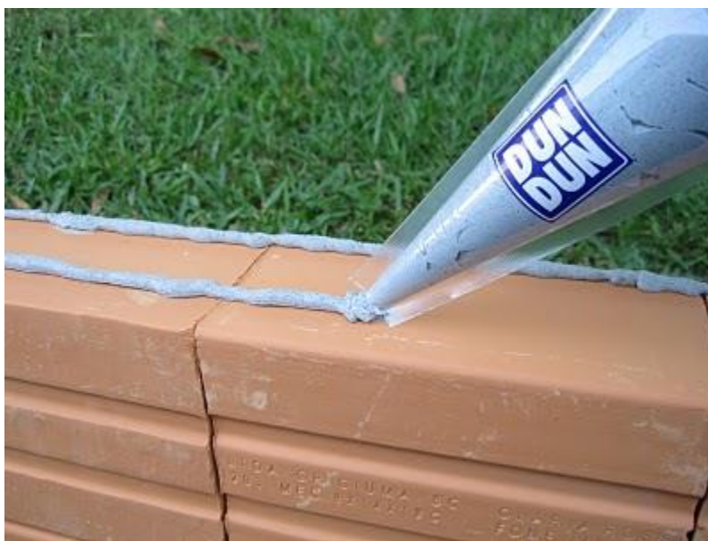
Figura 13– Aplicação da massa DunDun (GONÇALVES et al.,2013)
