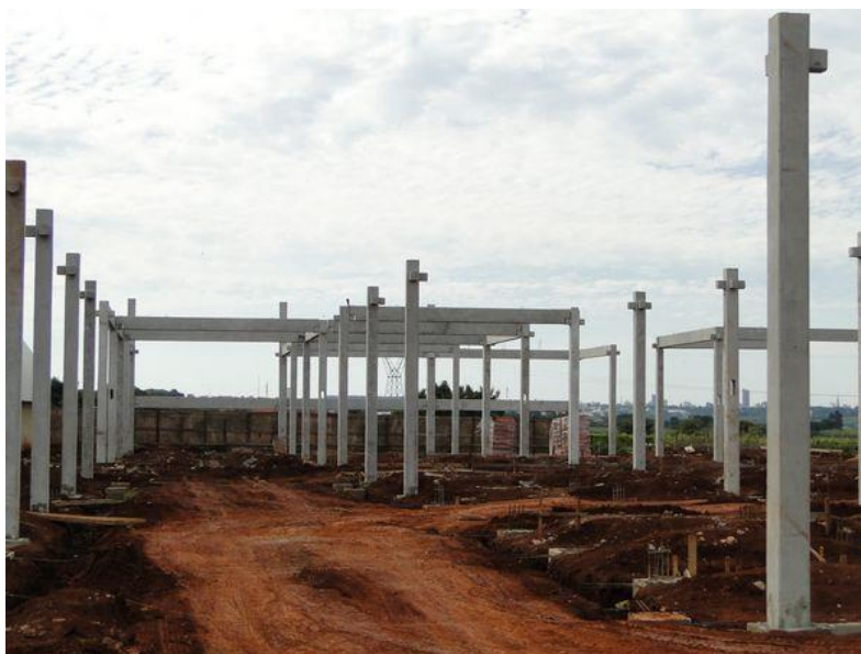
Figura 17– Estrutura de concreto pré-moldado (MODULAR,2014)
