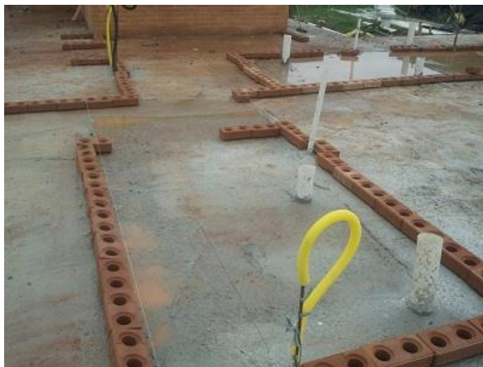
Figura 6– Primeira fiada de alvenaria (TIJOLOSOLOCIMENTO,2013)
