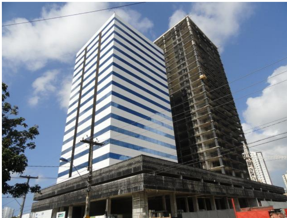
Figura 19- Fachada do Civil Towers – conclusão em 45 dias (CIVIL,2014)
