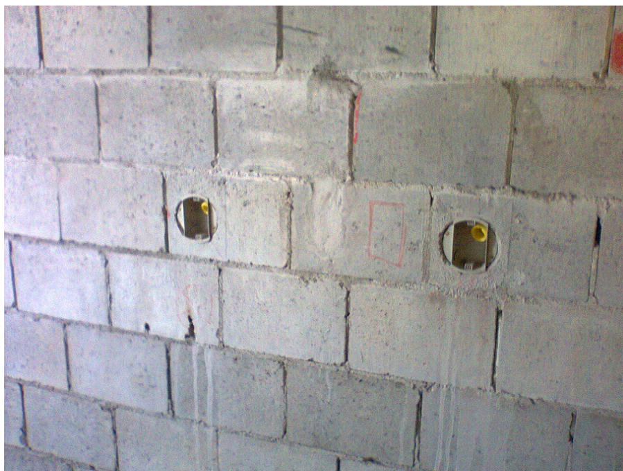
Figura 25: Obra West Residencial, Campo Grande, Rio de Janeiro.
