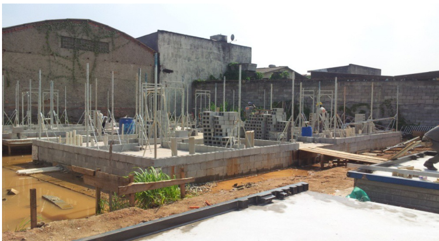
Figura 20: Obra West Residencial, Campo Grande, Rio de Janeiro.
