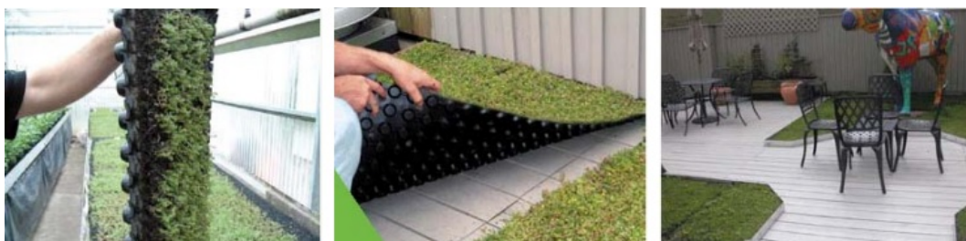
Figura 18 – Sistema da manta vegetativa pré-cultivada aplicada em uma cobertura residencial.
