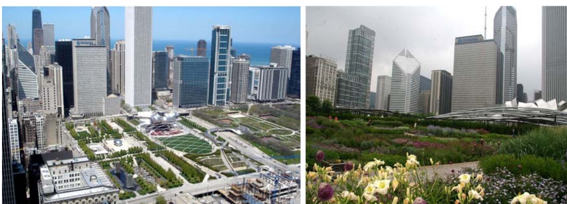
Figura 8 – Cobertura verde intensiva do Millenium Park em Chicago.
