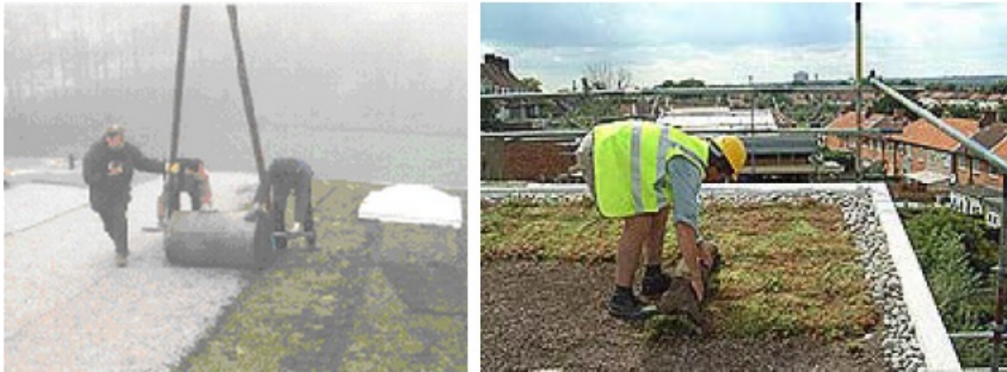
Figura 21 – Aplicação da manta vegetativa pré-cultivada através de desenrolamento. (Fonte: http://www.toronto.ca , acesso em fevereiro de 2015)
