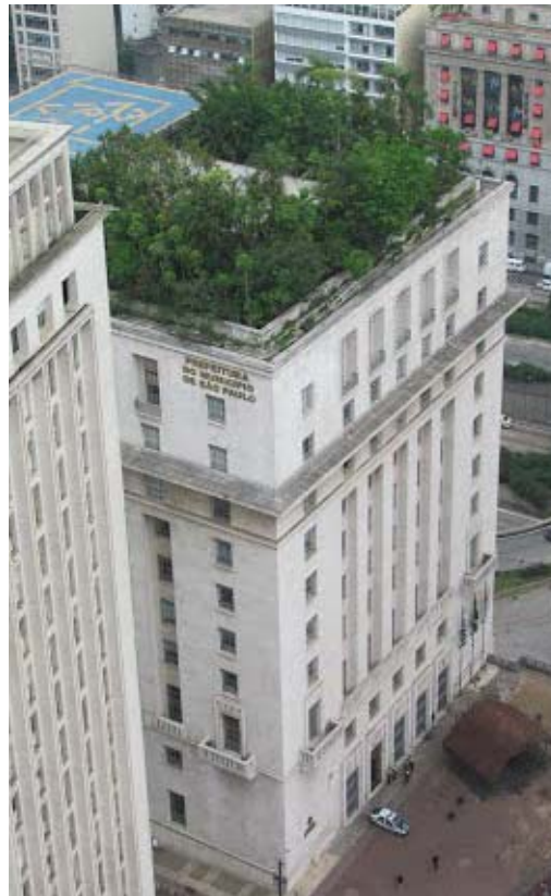
Figura 23 – Telhado verde do Edifício Conde Matarazzo, em São Paulo.
