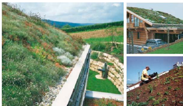
Figura 7 – Cobertura extensiva em telhado com inclinação em Rosswag, na Alemanha.
