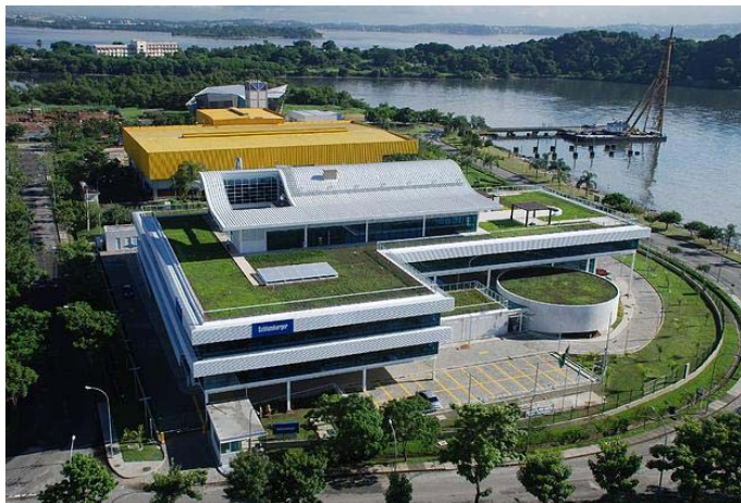
Figura 6 – Cobertura extensiva do prédio da Schlumberger, no Rio de Janeiro.
