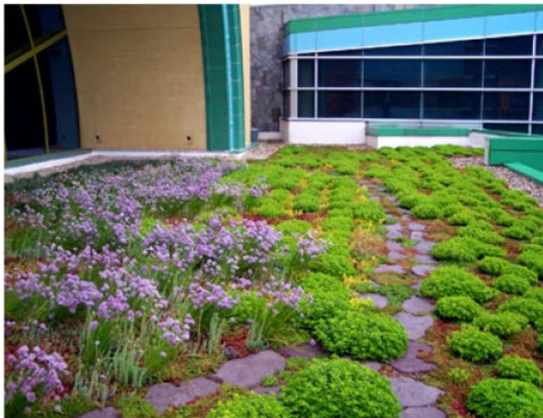
Figura 10 – Cobertura semi-intensiva em edificação em Boston, EUA. (Fonte: SAVI, 2012)
