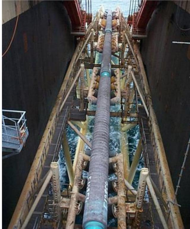
**Figura 28 – Duto sendo lançado com auxílio de stinger**
