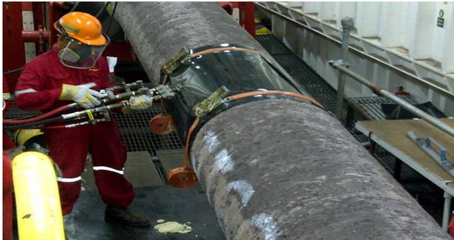
**Figura 34 - Aplicação do revestimento na conexão entre dois tramos**
