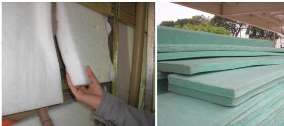
Figura 16: Fechamento interno CENPES II. a) Material isolante térmico fabricado a partir de garrafas pet transparente aplicado entre os Drywalls. b) Material isolante térmico fabricado com garrafas pet verdes. Finte: Machado (2010).
