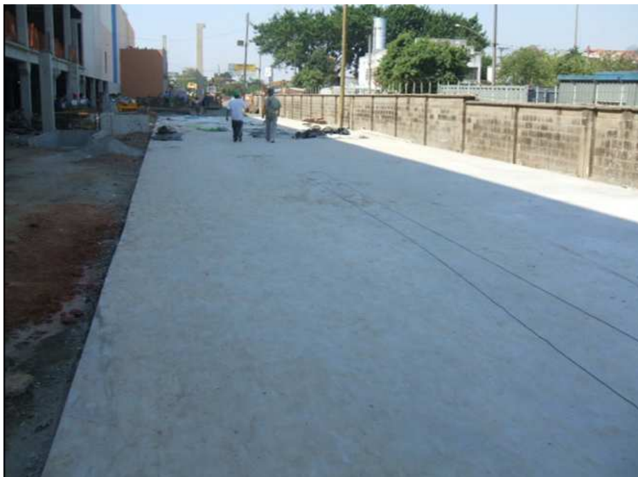
Figura 27: Pista para execução do Tilt-up
