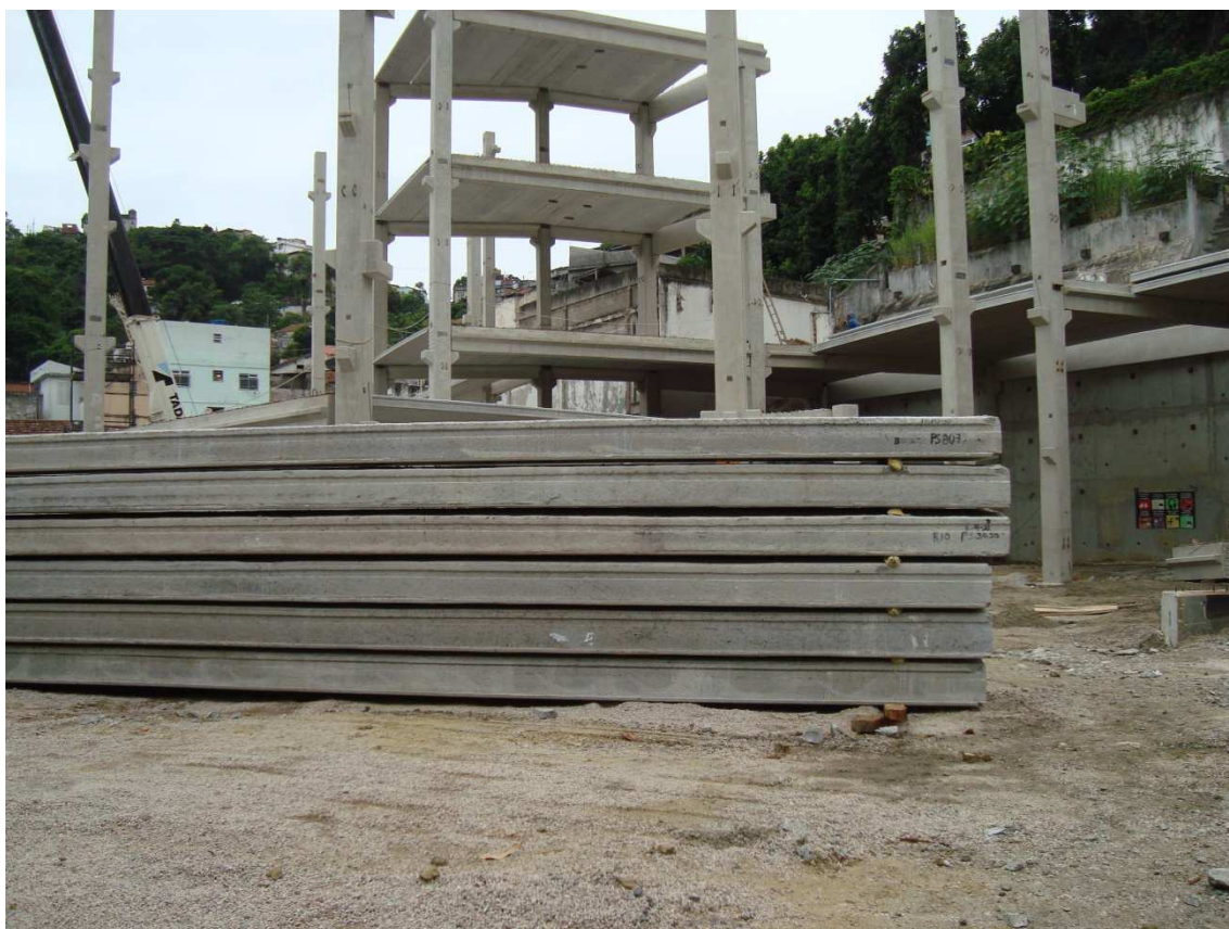
Figura 36: Detalhe laje alveolar apoiada por madeiras
