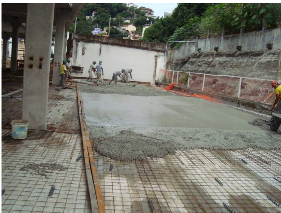
Figura 44: Detalhe da concretagem do capeamento
