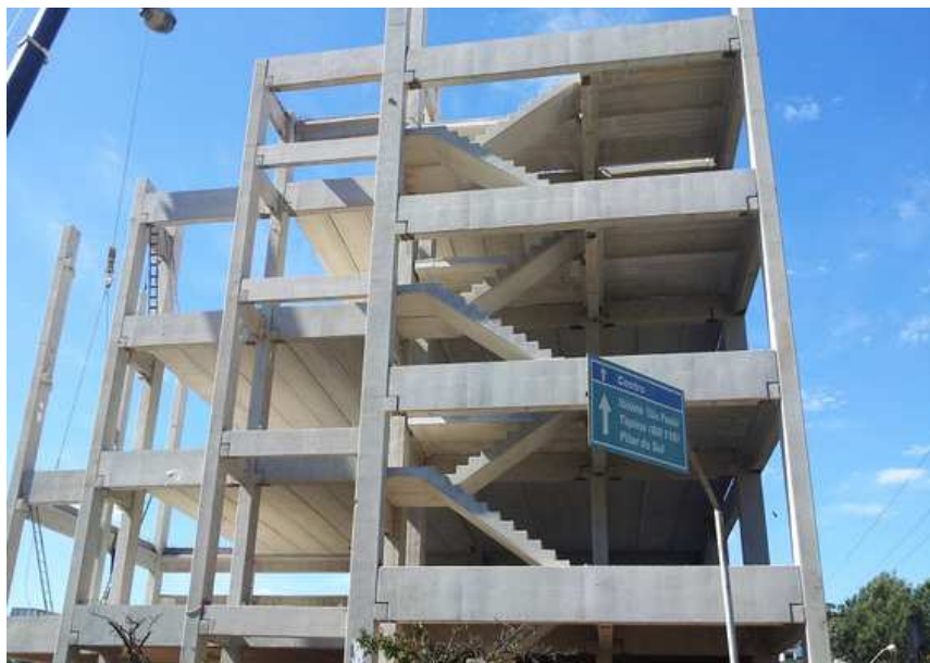
Figura 16: Detalhe do pilar com console pra gerber
