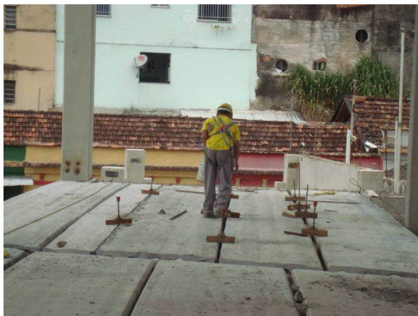
Figura 42: Execução da montagem dos torniquetes na obra
