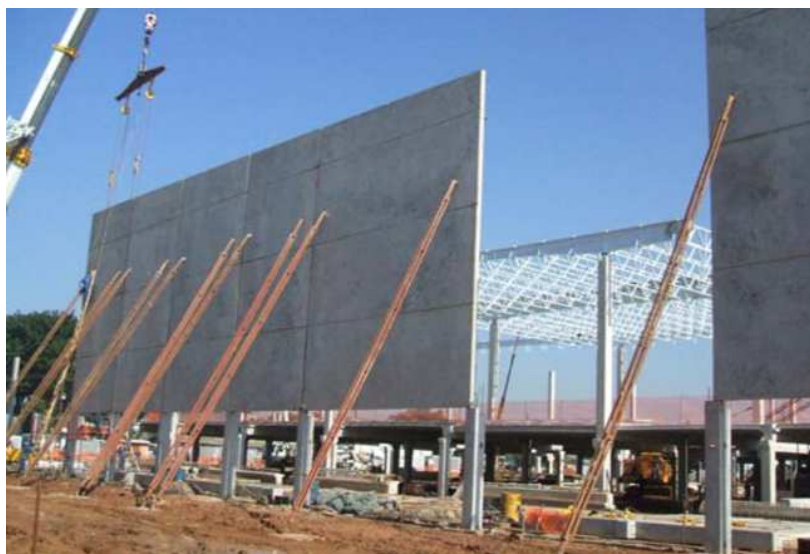
Figura 30: Detalhe do escoramento das placas de Tilt-up
