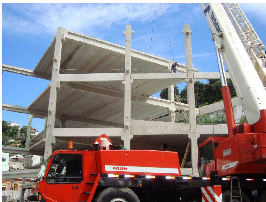
Figura 37: Içamento de viga retangular
