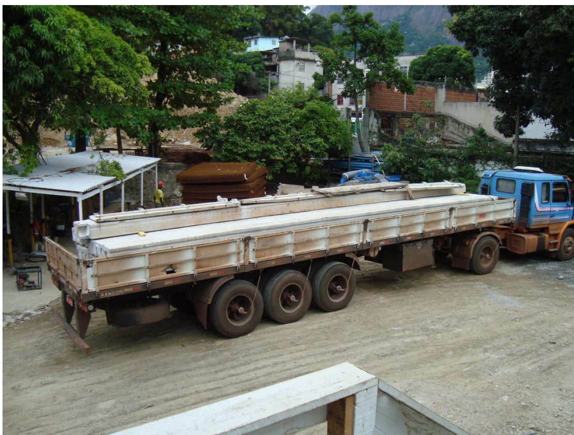
Figura 35: Detalhe carregamento de laje alveolar
