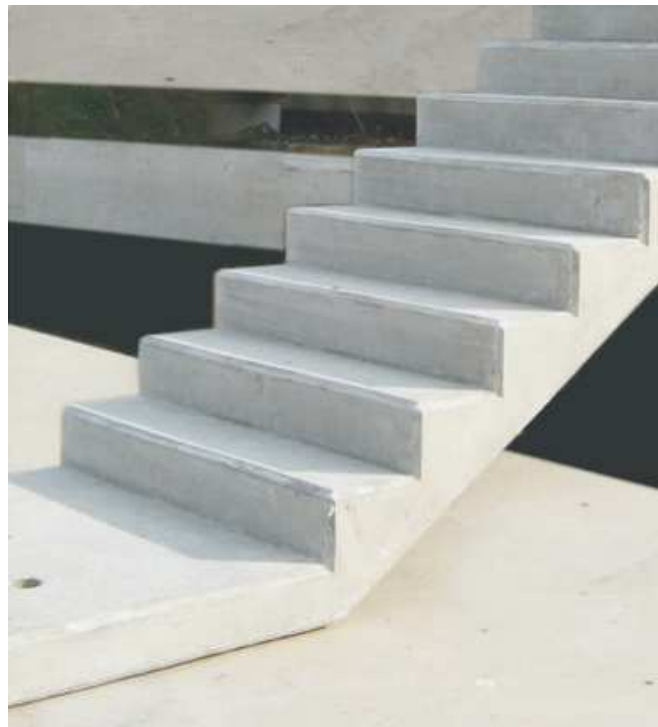
Figura 26: Detalhe da escada pré-moldada
