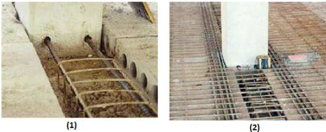
Figura 23: Armadura de continuidade viga x pilar
