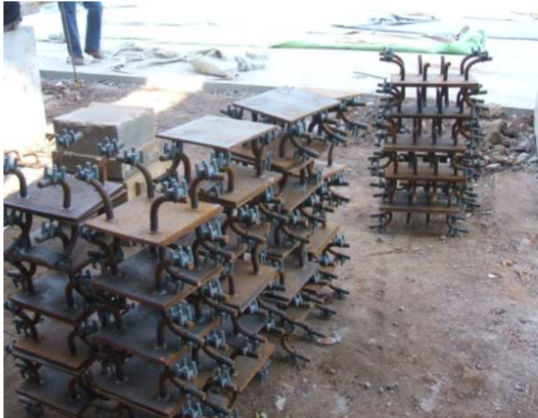
Figura 28: Detalhe inserts metálicos para fixação da estrutura
