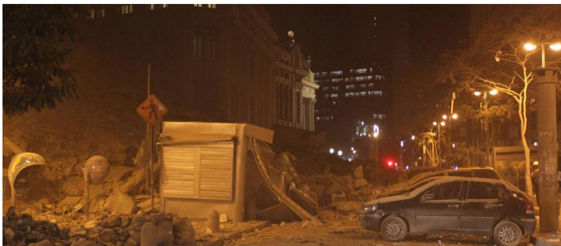
Figura 1 – Desabamento do Edifício Liberdade - Fonte: http://oglobo.globo.com/
