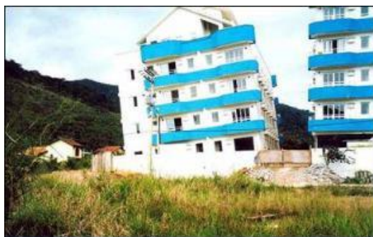
Figura 23 – Edificação com problemas de recalque - Fonte: http://www.ebah.com.br/
