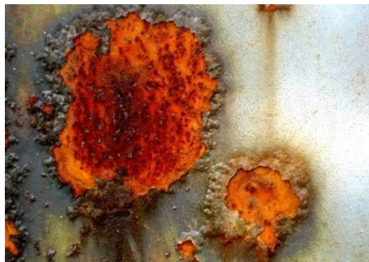
Figura 12 – Corrosão localizada - Fonte: http://www.masterzinc.com.br/
