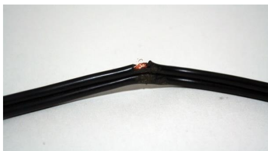
Figura 65 – Fio com isolamento danificado - Fonte: http://pt.wikihow.com/
