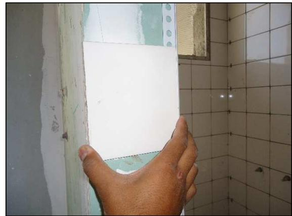
*Figura 4.12 – Corte de peça para se adequar ao vão (Obra RJ1).*
