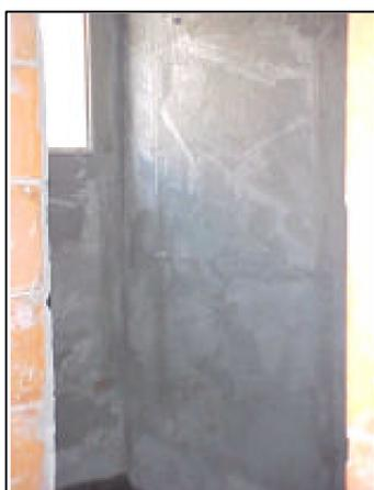
*Figura 4.4 – Base para assentamento das placas cerâmicas (Obras SP).
