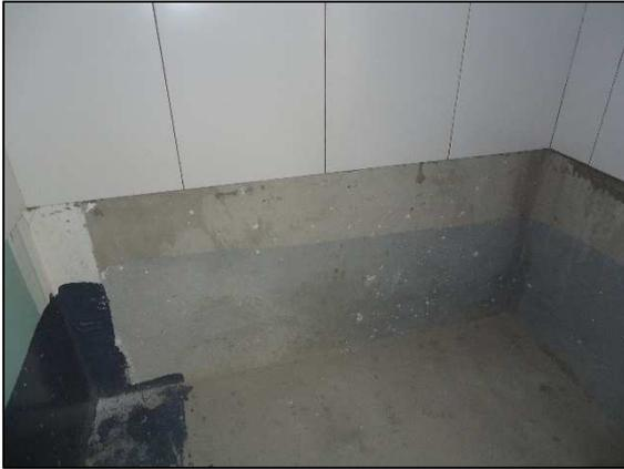
*Figura 4.9 – Base para assentamento das placas cerâmicas (Obra RJ1).*
