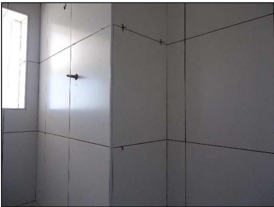
*Figura 4.10 – Utilização de espaçadores de plástico (Obra RJ1).*
