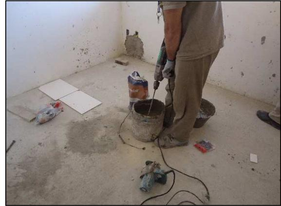
*Figura 4.11 – Preparo de argamassa colante em balde (Obra RJ1).*
