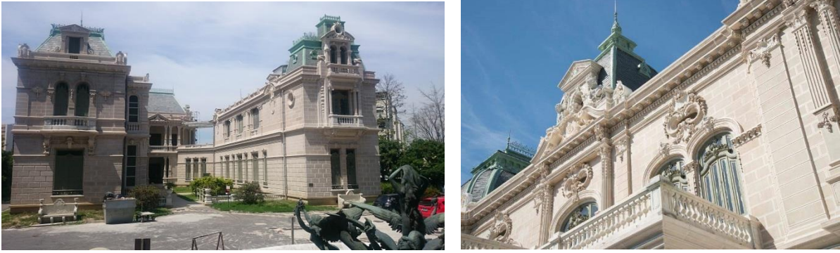
Figura 7.1: Fotos da entrada dos fundos e da fachada lateral do Palácio Laranjeiras
