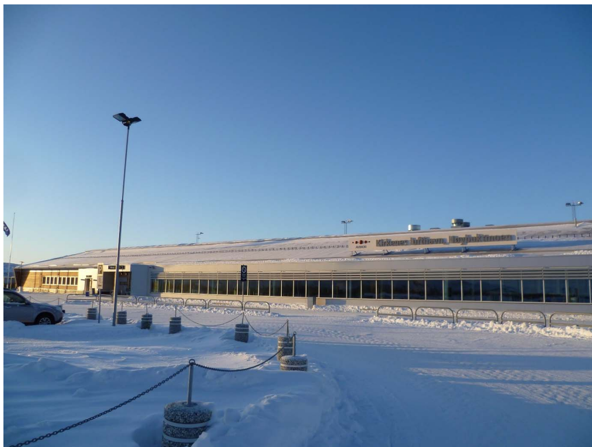
Figura 32 - Meio-fio de embarque e desembarque do Kirkenes Airport , além de parte do estacionamento de veículos (Fonte: Mapio) 37 .
