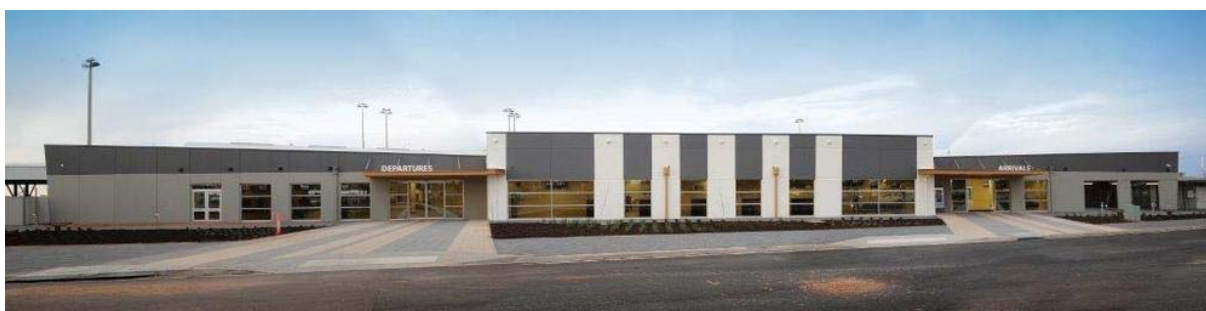
Figura 30 - Mildura Airport. Embarque e desembarque em um único nível. Destaque para o meio-fio equipado com rampas de acesso (Fonte: Regional Building Consultants) 34 .
