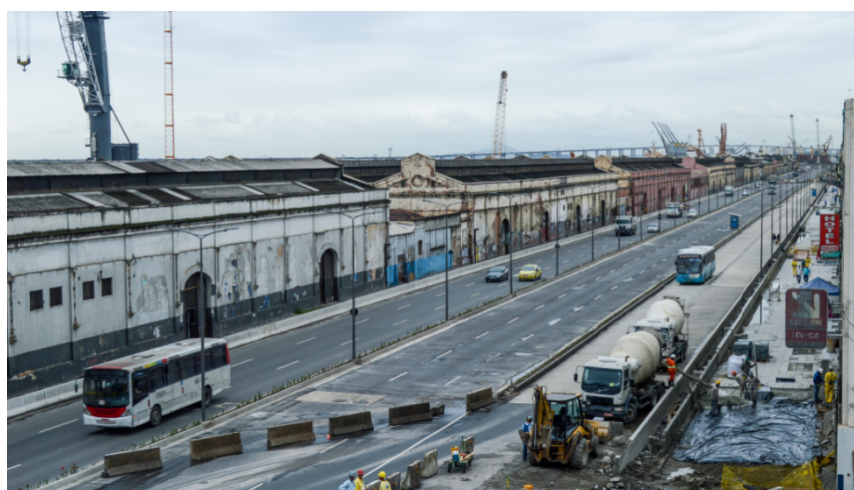
Figura 7. Obras na Avenida Rodrigues Alves para a transformação da Via Expressa.
