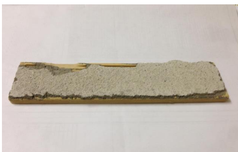
Figura 32: Placa retirada da fachada, evidenciando boa conexão entre a cerâmica e a argamassa de cola
