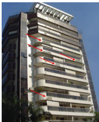
Figura 30: Fachada com pastilhas deslocadas. Fonte: OLIVEIRA (2013).
