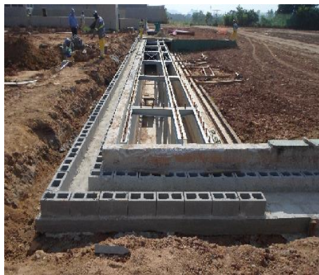
Figura 34: Execução das pedanas
