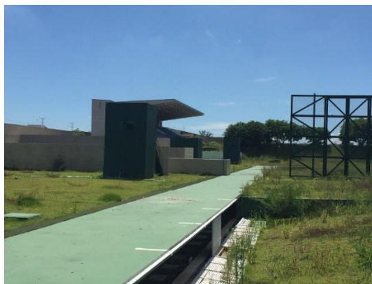
Figura 35: Lajes de pedanas de tiro refeitas. Fonte: O autor
