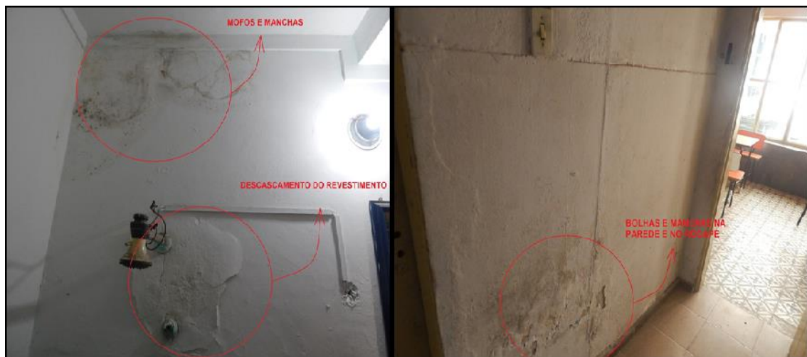
FIGURA 17 - Banheiro (à esq.) e Circulação (à dir.) - Próprio autor
