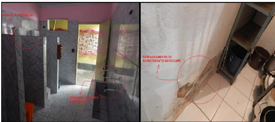
FIGURA 21 - Banheiro Feminino (à esq.) e Despensa (à dir.) - Próprio autor
