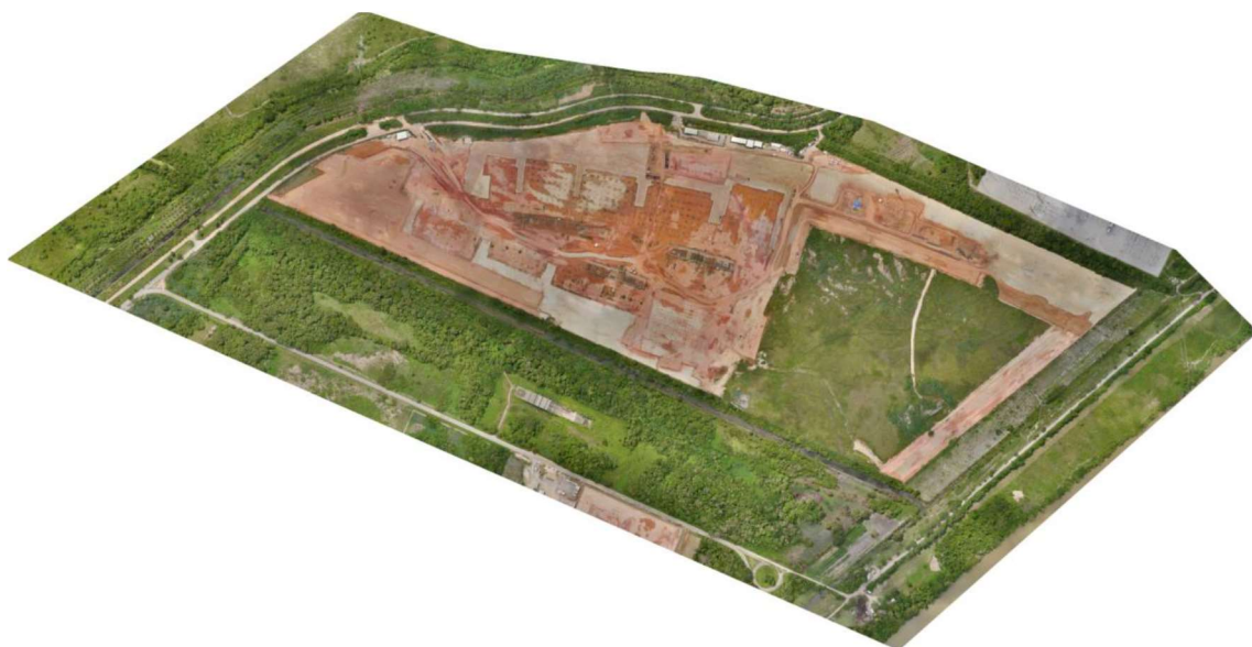
Figura 30 - Vista aérea da localização do terreno (FILHO, 2017)
