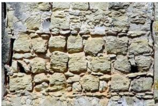
Figura 17 – Alvenaria de Pedra. Binda et al. , 2000, sugerem que sejam tiradas fotos da alvenaria e a partir destas seja determinado a porcentagem de pedra, argamassa e vazios existentes para uma caracterização preliminar da estrutura.
