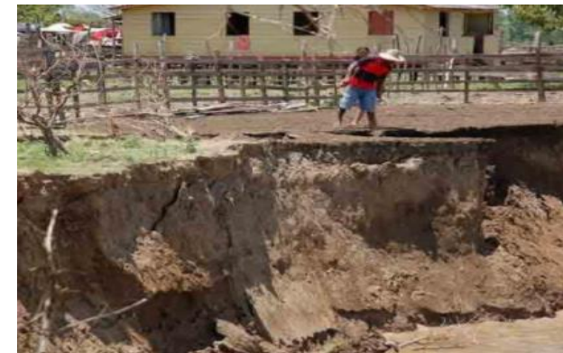
Figura 22 Solapamento de margem provocado por erosão fluvial. 9
