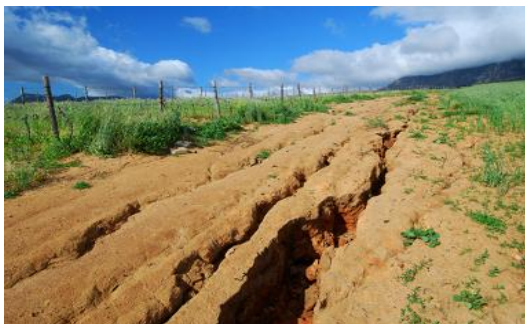
Figura 24 Formação de ravina no terreno 20 .
